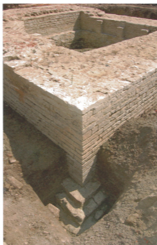
De getrapte fundering bij de westelijke hoek van de woontoren (foto D. Pauwels)
